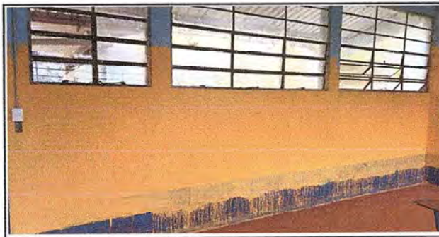
Foto 12: Sustitución de pintura de agua y aceite en muros interiores y exteriores
