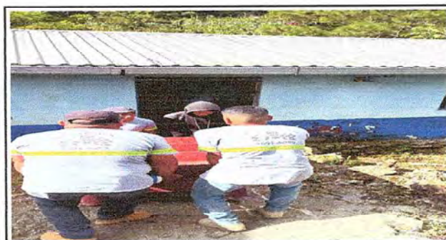
Foto 11: Sustitución de pila para lavaderos
