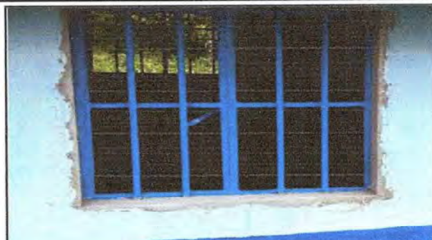
Foto 2: Sustrucción de ventana
