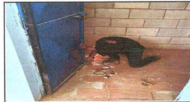
Foto 6: Reparación de puerta y cambio de chapa.
