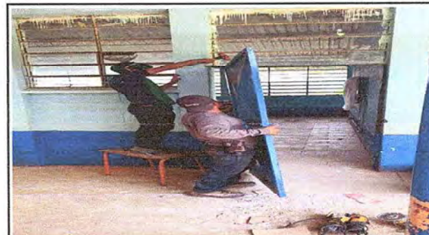
Foto 4: Sustrucción de puerta
