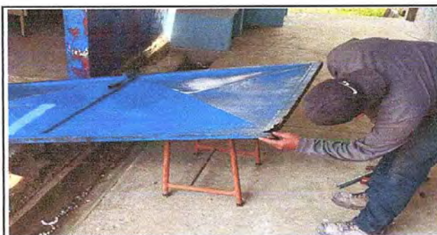
Foto 5: Reparación de puerta y cambio de chapa.
