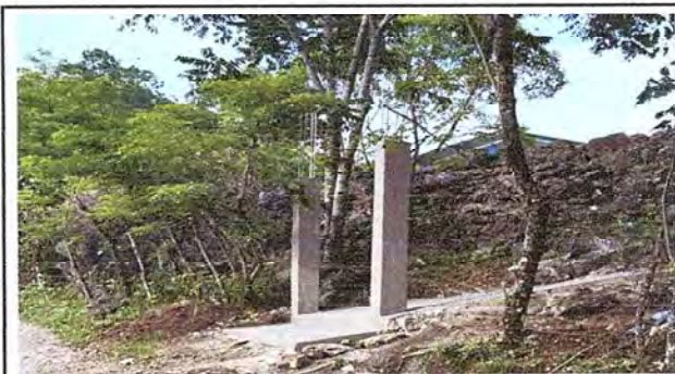
Foto 10: Sustitución de losa de patio
