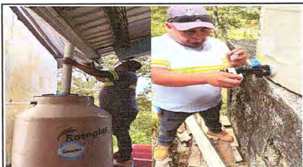
Foto 9: Sustitución de tinaco con tubería
