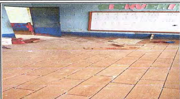
Foto 7: Cambio de piso de aulas
